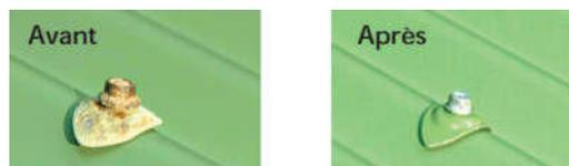
Attention au **nettoyage** des toitures avec des **produits chimiques** (Détergent, lessive, solvant, **chlore** ...) qui altèrent les matériaux de la couverture.
